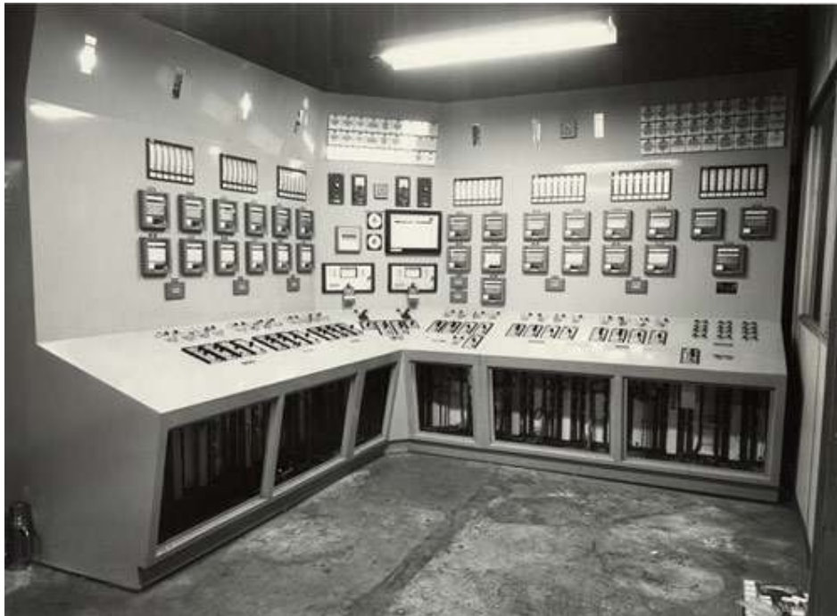
Figura 3.2: Armarios de control industrial según los estándares internacionales.
