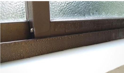
Evaporación y filtración de agua por sellado incorrecto en ventanas de PVC
