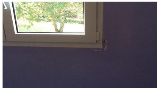
Ventana mal instalada, daño en pared por forzamiento de la misma.
