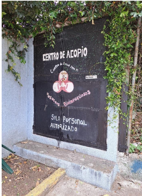
Figura No. 4. Centro de acopio de residuos infecciosos
