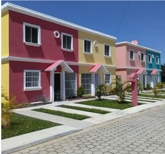
Fuente 4 vivienda remodelada
