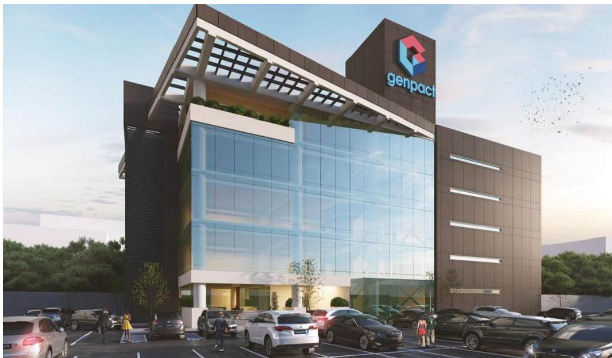
Instalación de Skyscrapercity Genpact Guatemala
