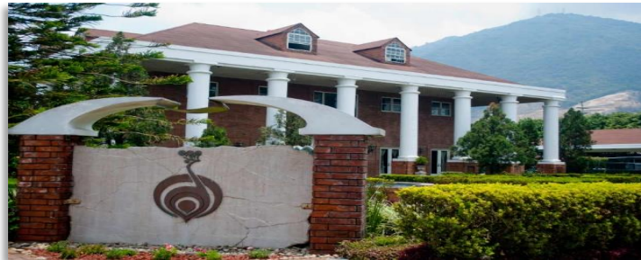
Figura 1: Modulo central de operaciones, Interior Corporación Liztex, Modulo de operaciones TENNAT S.A. Elaboración propia [fotografía], 2022.
